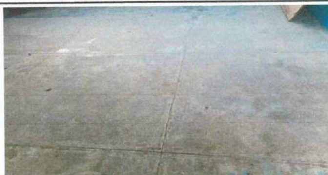
Foto 2: SUSTITUCION DE PISO LISO A PISO CERAMICO
