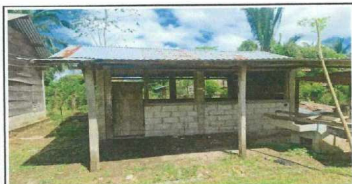
Foto 5: ESTRUCTURA DE TECHO Y CUBIERTA DE LAMINA PARA MEJORAMIENTO DE NUESTRA COCINA
