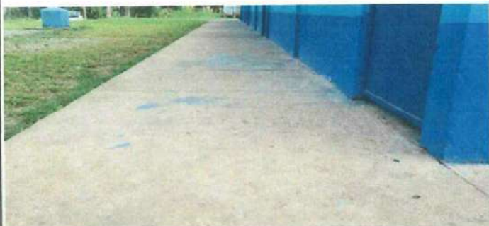
Foto1: SUSTITUCION DE PISO DE PISO DE PATIO
