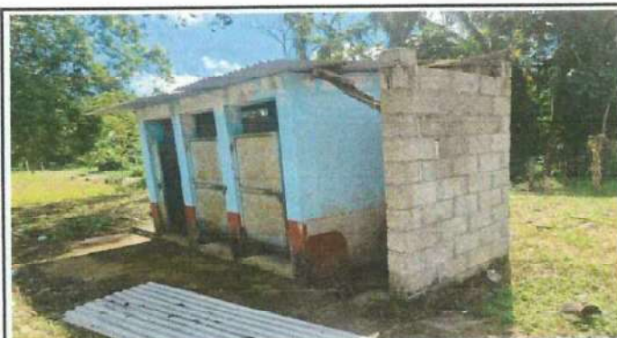
Foto 4: SUSTITUCION DE ESTRUCTURA DE TECHO, CUBIERTA DE LAMINA, PUERTAS EN MAL ESTADO Y PINTURA INTERIOR Y EXTERIOR
